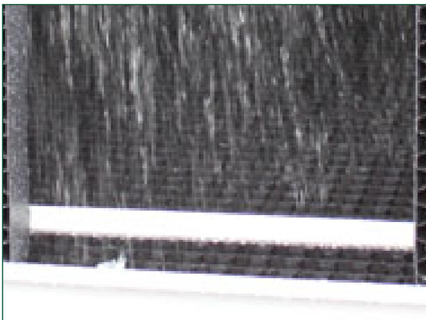
Posti nella vasca, gli attenuatori dello scroscio dell'acqua **riducono il rumore** della caduta dell'acqua. Si possono rimuovere facilmente in **moduli** per le operazioni di ispezione o pulizia.
