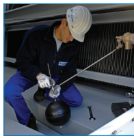
обслуживание на объекте
