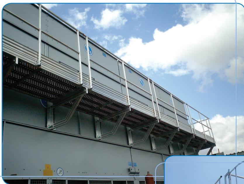
Torre di raffreddamento a circuito chiuso BAC Modello VXI con attenuatore di rumore in scarico
