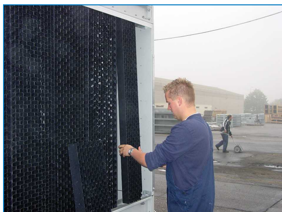
Снятие комбинированных щитов на входе
