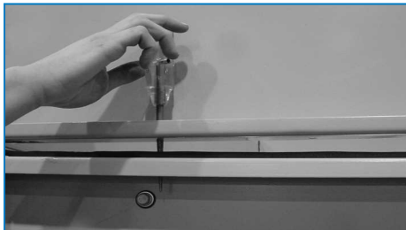
Verwendung des Treibdorns zur Ausrichtung der Schraublöcher
