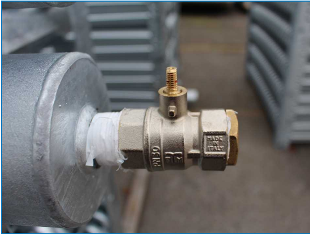
Oberer Anschluss des Rohrbündels mit Überdruckventil auf Kühltürmen mit geschlossenem Kreislauf und Anschlüssen größer als ND100.
