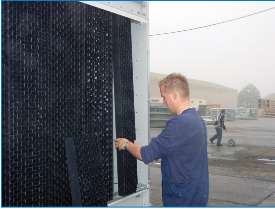
Démontage des déflecteurs d'entrée d'air
