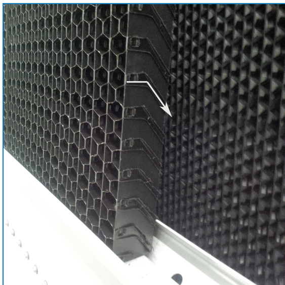
Orientation des déflecteurs d'entrée d'air à 3 fonctions
