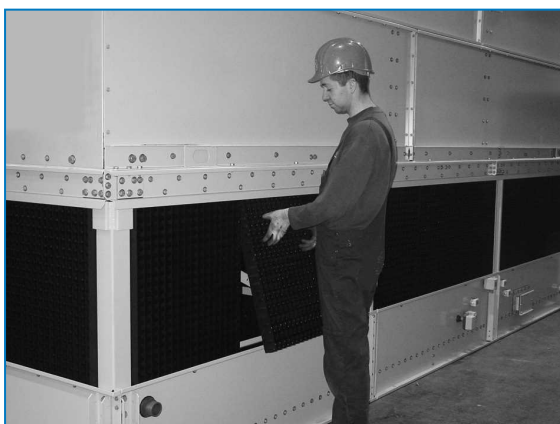
Démontage des déflecteurs d'entrée d'air
