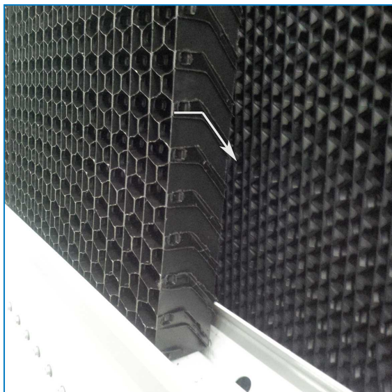
Orientation des déflecteurs d'entrée d'air à 3 fonctions
