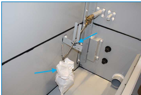
Fixation et emballage du flotteur sphérique
