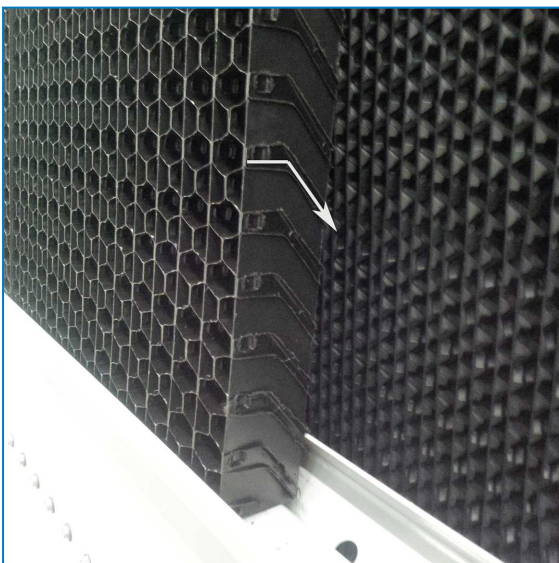
Orientación del filtro de acción múltiple
