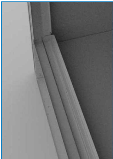
Grondaia di raccolta dell'acqua
