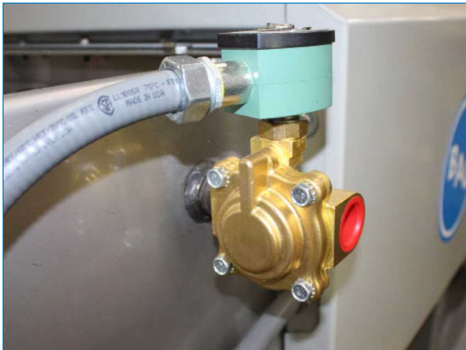
Valvole a solenoide di drenaggio
