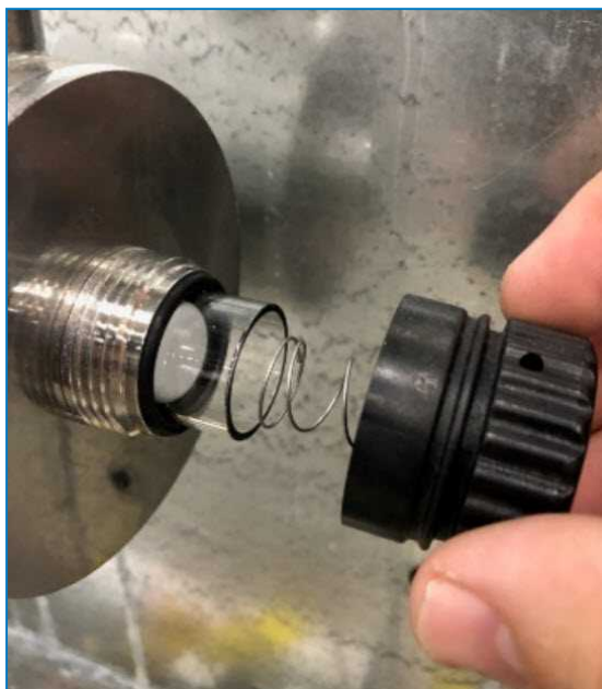
Rimozione del manicotto di quarzo UV
