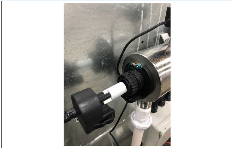
Sostituzione della lampada
