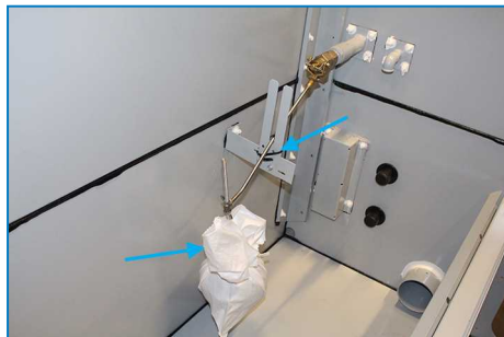
Befestigung und Umhüllung der Schwimmerkugel
