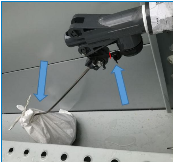
Befestigung und Umhüllung der Schwimmerkugel
