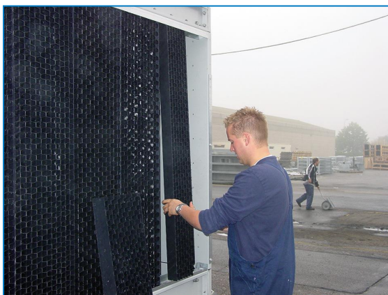
Kombinierte Lufteintrittsschutzelemente entfernen
