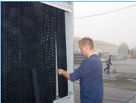
Kombinierte Lufteintrittsschutzelemente entfernen
