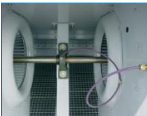
Des lignes de lubrification prolongées équipées de graisseurs facilement accessibles peuvent être mises en œuvre pour lubrifier les paliers d'arbre de ventilateur. [En savoir plus](#)
